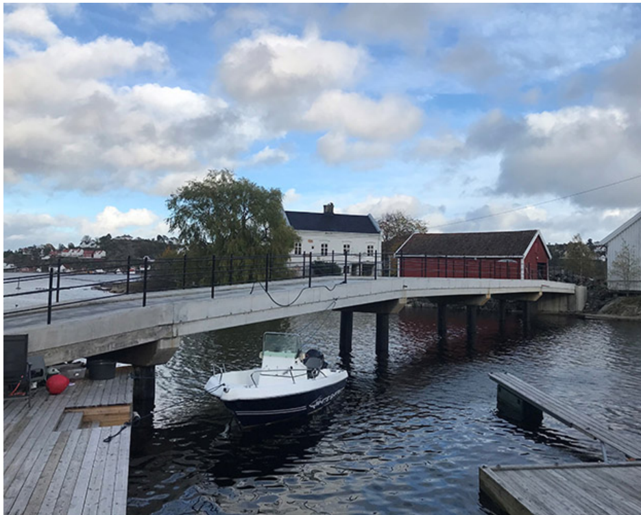
Nyanlagd betongbro från Sperrivigveien i Kolbjørnsvik till Jomfruholmen i Norge.
